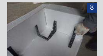
Зафіксувати плити теплоізоляції кутовим кріпленням.
