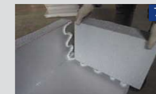
Приклеїти теплоізоляційні плити на іншому торці. Нанести КЛЕЙ-ПІНУ для пінополістиролу на плиту. Зачекати 5-7 хвилин після нанесення клею і встановити торцеву плиту.
