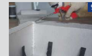
Зазори між плитами заповнити КЛЕЙ-ПІНОЮ для пінополістиролу.
