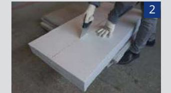
Провести підготовку торцевих елементів незнімної опалубки фундаменту, підрізавши плити в розмір.
